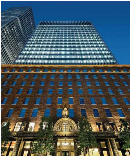
地上22階のダイビル本館。下層階は大正時代に建設されたダイビルを復元し、その上にガラスカーテンウォールを採用した高層部を組み合わせた。
