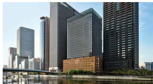
堂島川対岸北西より臨むダイビル本館。左は中之島ダイビル、右は関西電力本社ビル。
