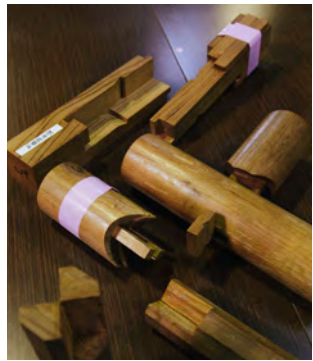
幾種もの継手を駆使する
